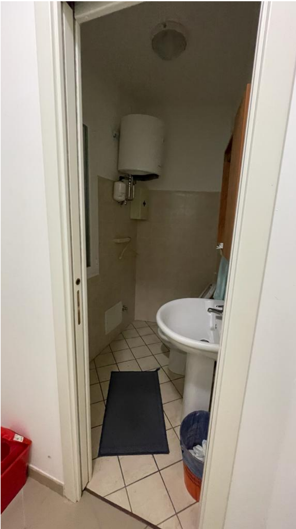
Veduta servizio igienico
